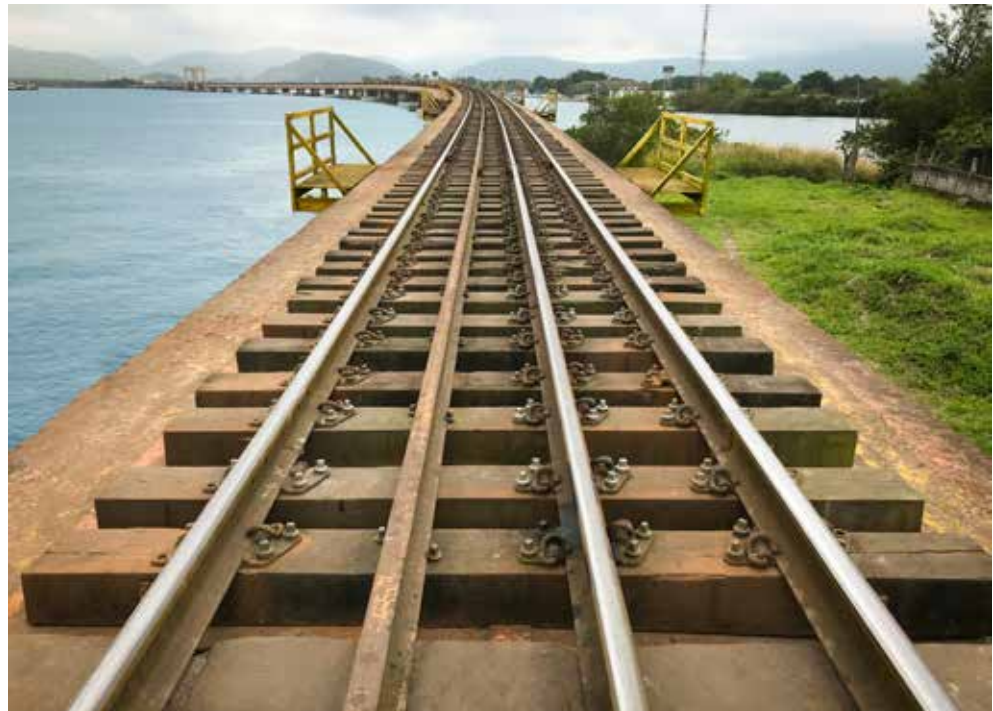
→ FIGURA 20: FERROVIA COM TERCEIRO TRILHO - PORTO DE SANTOS/SP.
