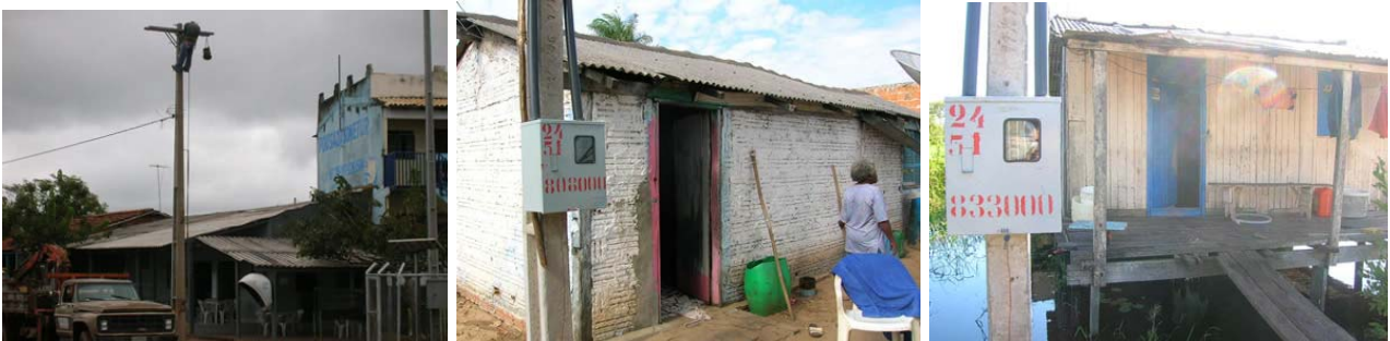
A Associação da comunidade centenária do Porto da Manga lutou durante cinco anos para adquirir luz elétrica – Energia foi instalada em junho de 2007.
