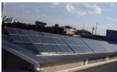
Obras de grande porte
