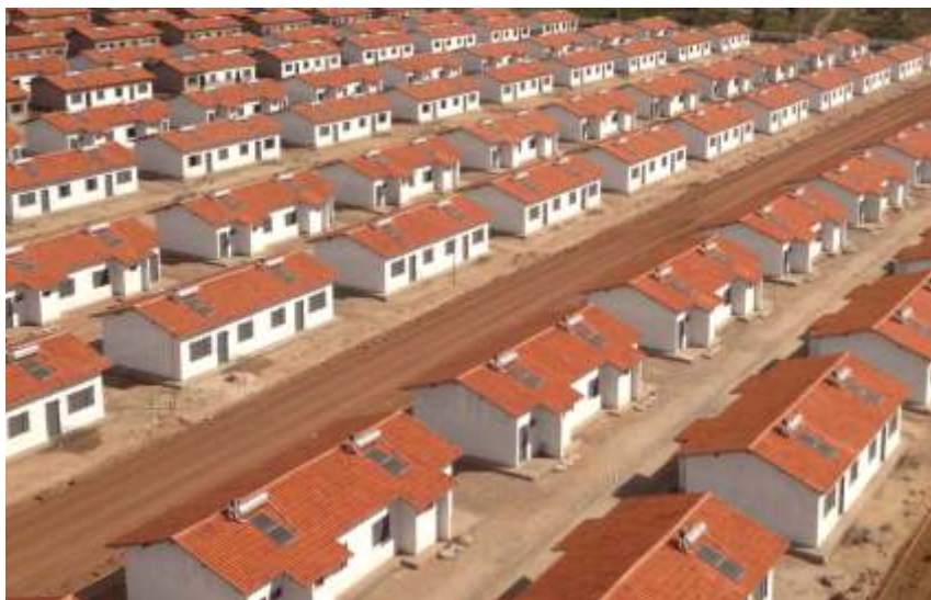
Aquecedores solares de água instalados em conjunto habitacional
