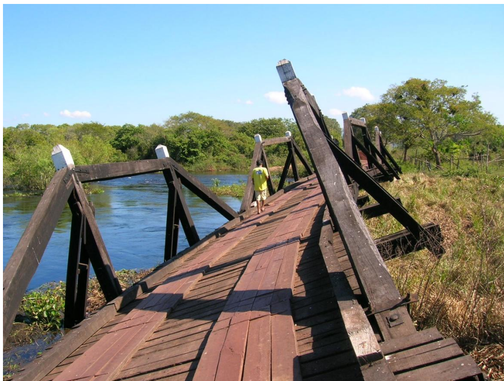
FIGURA 11 – Ponte de madeira da EPP arrastada pela água durante o período das cheias. Foto: Jean Fernandes (2008).
