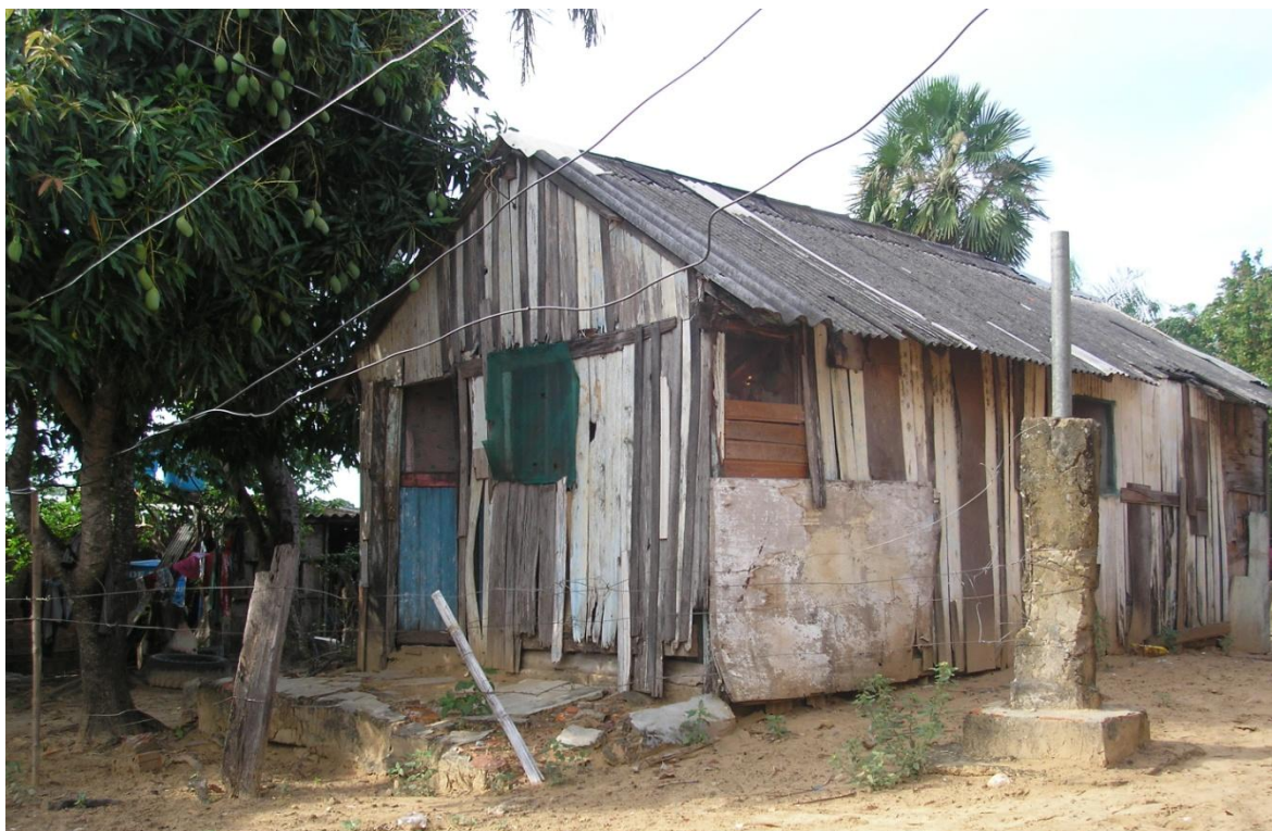
FIGURA 6 - Casa construída no 'areão' pertencente à comunidade ribeirinha de Porto da Manga Foto: Jacir Zanatta (2011).
