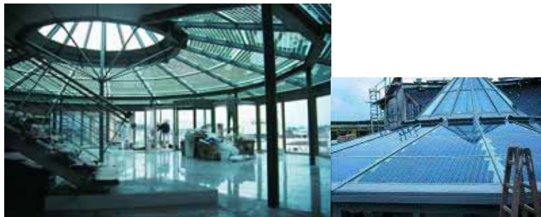
Figura 8.173 - Empresa Pressevertrieb IPS em Meckenheim, Alemanha Telhado quente Módulos de vidro isolante: Saint Gobain Sistema montante-travessa Schüco
