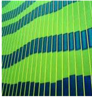
Figura 8.87 - 50 kW p Solartec sobre estrutura ondulada na fachada industrial no ThyssenKrupp Stahl em Duisburg-Beeckerwerth, na Alemanha
