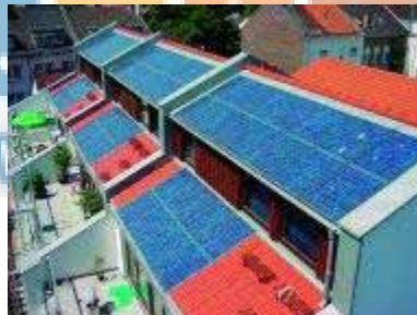
Figura 8.58 - Sistema de secções Energiedach Fotografias: Solarworld
