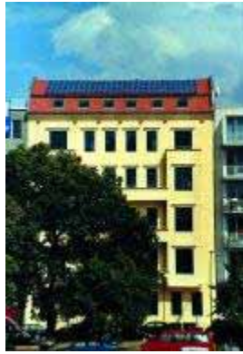
Figura 8.16 - Sistema fotovoltaico montado na Sede do Partido Federal Alemão dos Verdes, Berlim
