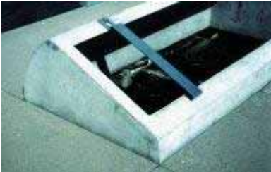
Figura 8.134 - Blocos de betão Sofrel União de laminados sem armação aos grampos de aço inox. Fotografia: Solstis
