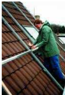
Figura 9.13 – Montagem das secções horizontais de fixação dos módulos
