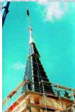
Figura 8.185 - Cume da igreja de Kirchsteigfeld em Potsdam, Alemanha Laminados vidro-vidro GSS
