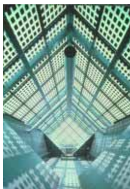
Figura 5.42 - Universidade Industrial de Nippon, em Tóquio Estrutura envidraçada de isolamento com placas de vidro aramado típicas do Japão em que o painel interior cumpre os requisitos de protecção contra o fogo
