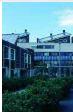
Figura 8.2 - No bairro residencial do estado de New Sloten em Amsterdam, os painéis fotovoltaicos estão integrados nos edifícios de formas diversas
