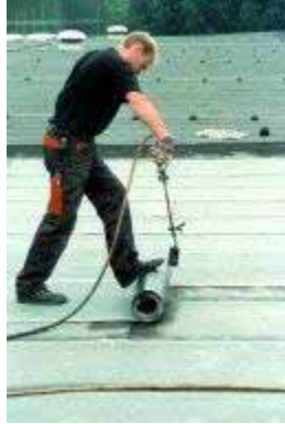
Figura 8.9 - Assentamento da membrana betuminosa Fotografia: A. W. Andernach
