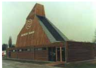
Figura 8.86 - 1,7 kWp Solartec “Style” em aço inoxidável, no Nautineum Dänholm Stralsund, uma divisão do Museu Oceanográfico Alemão
