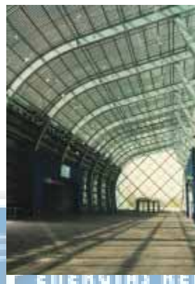
Figura 5.40 - “Galeria” no Centro de Exibições de Essen. Os painéis interiores do envidraçado isolante são feitos de vidro laminado de segurança
