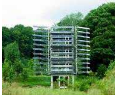
Figura 8.202 - Torre Tecnológica Wertal em Ohrberga na Hameln-Emmerthal, na Alemanha Estores horizontais Laminados GSS Sistema fotovoltaico Colt
