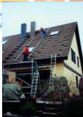
Figura 9.8 – Instalação dos ganchos do telhado
