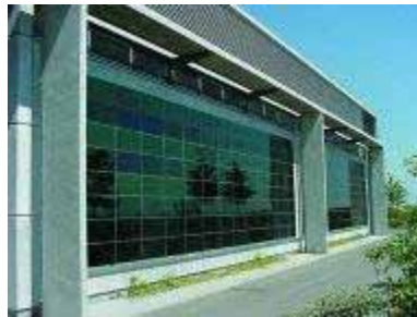
Figura 2.87 - Edifício industrial com módulos ATF em Flörsheim, Alemanha Fotografias: Antec
