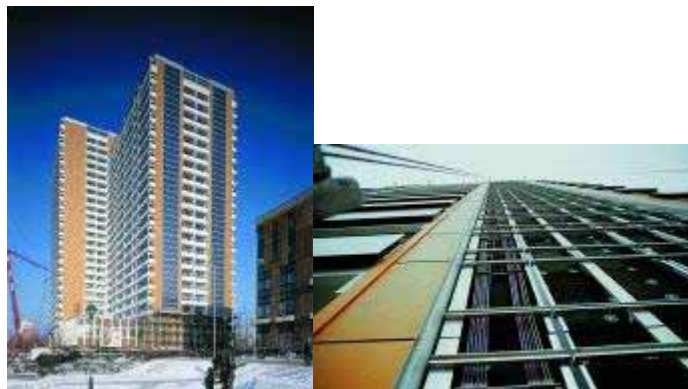
Figura 8.157 - Edifício residencial de Helene-Weigel-Platz, em Berlim Fachada fria Módulos vidro-vidro Saint Gobain Desenho Ikarus
