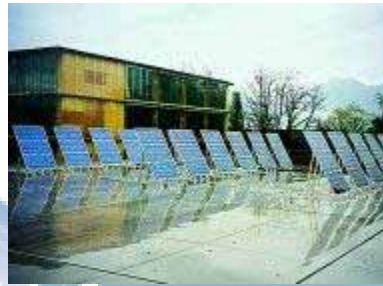
Figura 8.111 - Montagem sobre placas de betão Montagem: Stromaufwärts
