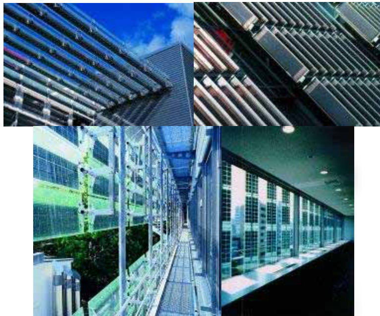
Figura 8.203 - fixações pontuais Laminados vidro-vidro Sólón; sistema Ado Solar Fotografia: Solon AG, Wolfram Murr
