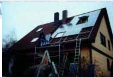
Figura 9.15 – Inserção dos módulos
