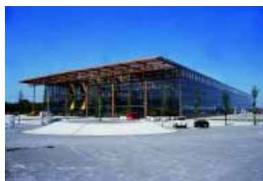
Figura 5.7 - Sistema fotovoltaico de 1 MWp da Academia de Ensino Superior em Herne (Alemanha)
