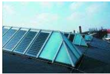
Figura 8.188 - Arena em Berlim Telhado quente Módulos de vidro isolante Saint Gobain
