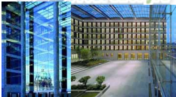
Figura 8.146 - Átrio do Gabinete Extranjeiro Federal em Berlim Parece envidraçada com rede de cabos Engenheiros: Schlaich Bergemann and Partners Fotografia: Müller Reimann Architekten
