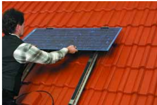
Figura 8.40 - Sistema de montagem fotovoltaico PV 1600 - sequência da montagem Fotografias: Lafarge Dachsysteme
