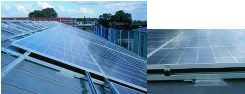
Figura 8.22 - Suporte de montagem com abertura metálica
