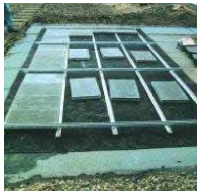
Figura 8.113 – Esquerda: Lastragem com lajes de betão inseridas em secções metálicas e Direita: Armação de metal fixada em lastros de betão Montagem: Donauer Solartechnik
