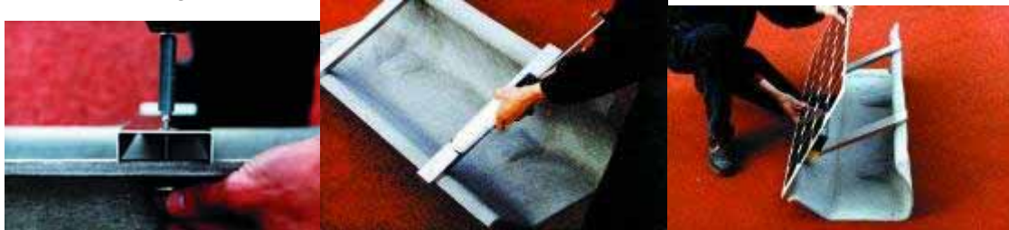
Figura 8.118 - Montagem de um laminado sem armação
