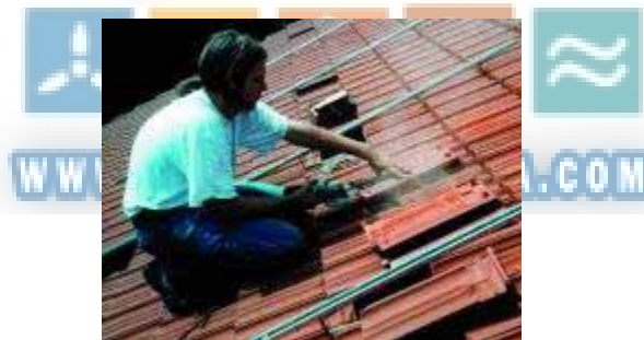
Figura 9.10 – Recorte das telhas
