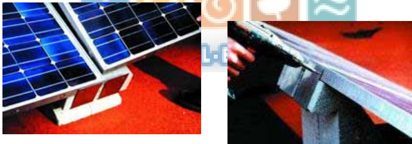
Figura 8.116 - Montagem de um módulo
