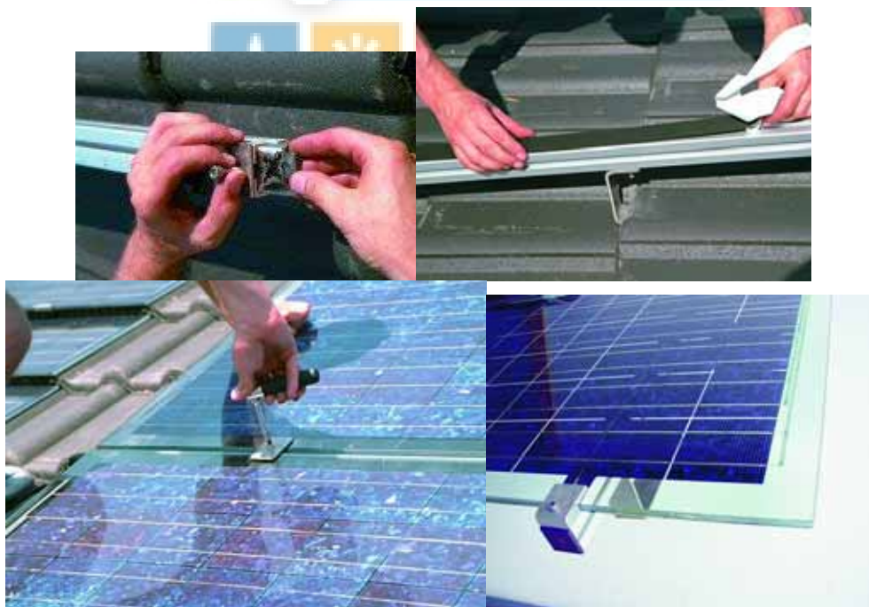
Figura 8.39 - Sequência da montagem Fotografias: Abakus
