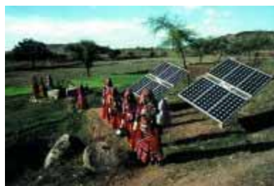
Figura 2.13 – Sistema solar de bombagem de água para garantir o fornecimento de água potável Imagem: Fa. Siemens
