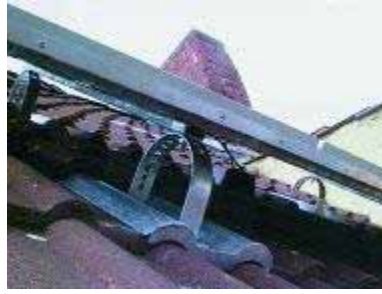
Figura 8.25 - Telha de fixação de plástico [Klöber]
