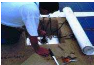
Figura 8.130 - Ligação dos cabos através da camada de isolamento térmico
