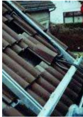
Figura 9.16 – Inserção dos cabos através de uma telha de ventilação
