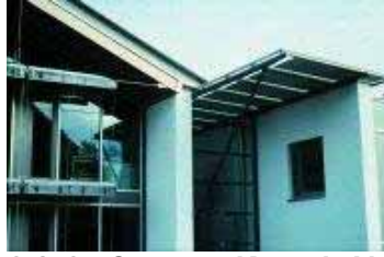
Figura 8.178 - Casa em Kassel, Alemanha Telhado frio Módulos vidro-vidro Flabeg Fotografia: Hegger/Architekten
