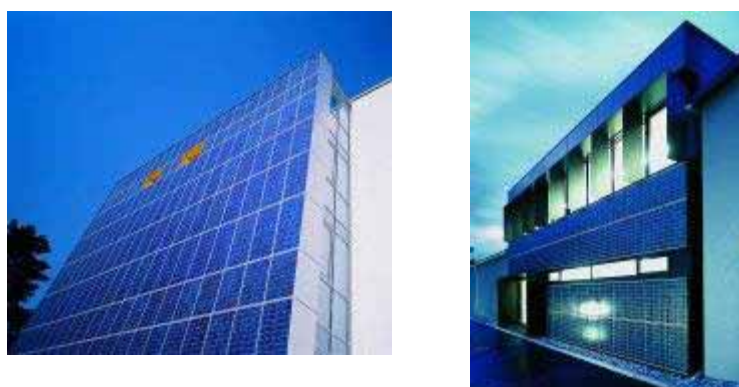
Figura 8.168 - Esquerda: Edifício residencial em Sonnenpark Dornbirn, Áustria e Direita: Empresa Metzler em Feldkirch, Áustria
