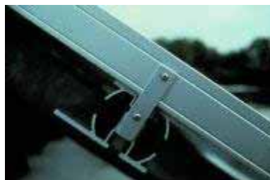
Figura 8.31 - Grampo entre dois módulos com armação
