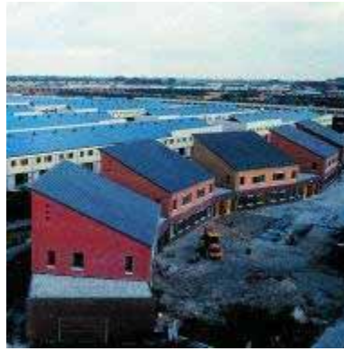
Figura 8.63 - 1 MW Residência Estatal 'Nieuwland', perto de Amersfoort, na Holanda, em primeiro plano, sistema Braas PV 700 Fotografia: Remu
