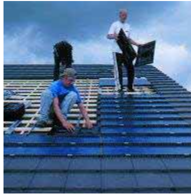
Figura 8.67 - PV 700 com telhas Tegalit Fotografia: Remu
