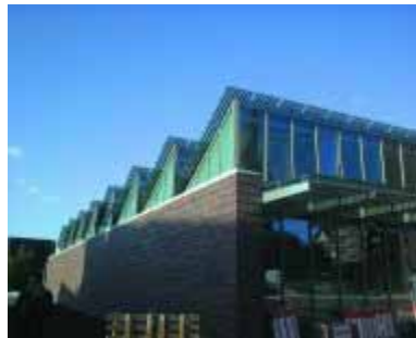
Figura 3.34 - Módulos de 4m de comprimento e 1m de largura no telhado em forma de dente de serra do Museu Arqueológico de Herne, Alemanha Módulos: Flabeg Solar
