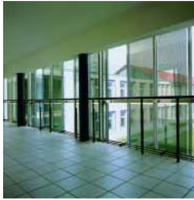
Figura 3.29 - Universidade de Ciência Aplicada Trier-Birkenfeld, Alemanha Módulos: RWE Solar
