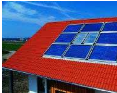
Figura 8.103 - Integração no telhado de módulos fotovoltaicos, colectores térmicos e janela de sótão
