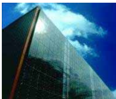
Figura 2.80 - Fachada solar no centro de investigação Joint Research Centre em Ispra, em Itália Fotografia: Flabeg
