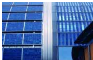
Figura 3.26 - Fábrica de células solares da Shell em Gelsenkirchen, Alemanha
