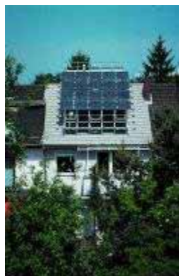
Figura 8.198 - Casa com terraço em Colonha Fotografia: Architect Wilhelm Schulte, Cologne
