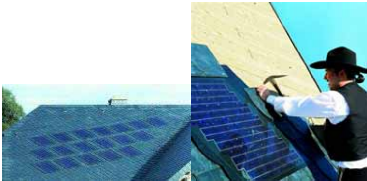
Figura 8.71 - Colocação e vista final das telhas SolarSklent
