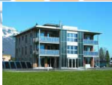
Figura 5.41 - Parque de demonstração de energias renováveis em Garms, Suíça. Parapeito do balcão: envidraçado vertical Módulo fixado na estrutura de ferro do corrimão
