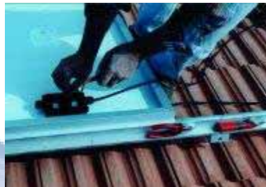
Figura 9.14 – Ligação dos módulos
