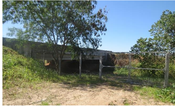
Figura 17. Cerca com portão de acesso instalada em ponte na BR-101/RJ. Foto: Helio Secco.
