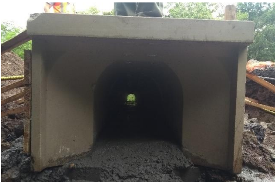
Figura 24. Implantação de túnel climático em concreto polímero para anfíbios na Rota do Sol/RS. Foto: Caroline Zank.
