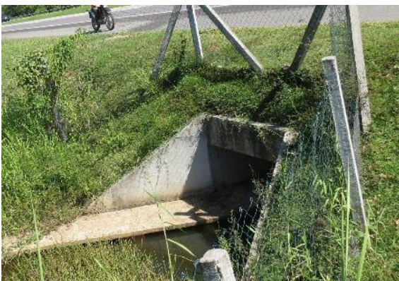
Figura 22. Passagem de fauna mista com passarela, associada a cercamento na BR-101/RJ. Foto: Helio Secco. Neste caso, recomenda-se que a cerca seja implantada sobre a ala de concreto da embocadura, para que não exista vão entre a cerca e a estrutura de passagem.
