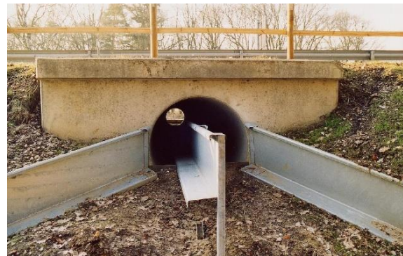
Figura 12. Cercas com a extremidade superior dobrada para evitar fuga de animais para a pista, direcionando para túnel de sapos. Foto: editada de Christian Fischer, obra original sob licença CC BY-SA 3.0 ( http://creativecommons.org/licenses/by-sa/3.0/ ), via Wikimedia Commons.
