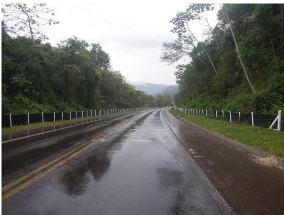
Figura 9. Cerca com plástico durável para anfíbios dos dois lados da rodovia Rota do Sol/RS. Foto: Caroline Zank.
