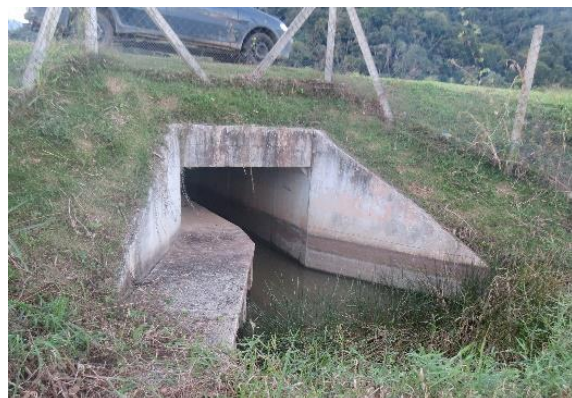
Figura 23. Passagem de fauna mista com passarela, associada a cercamento na BR-101/RJ. Foto: Helio Secco. Neste caso, recomenda-se que a cerca seja implantada sobre a ala de concreto da embocadura, para que não exista vão entre a cerca e a estrutura de passagem.
