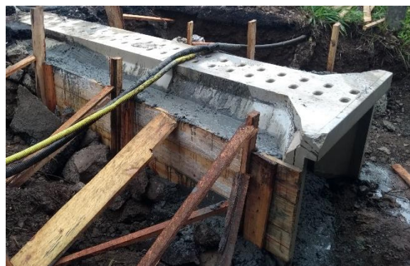
Figura 25. Instalação de túnel climático em concreto polímero para anfíbios na Rota do Sol/RS. Foto: Caroline Zank.
