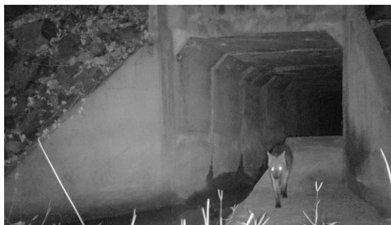
Figura 15. Exemplo de galeria de 1,5 m x 1,5 m com plataforma seca: cachorro-do-mato (animal terrícola) utilizando a parte seca. Foto: Robson Siqueira.
