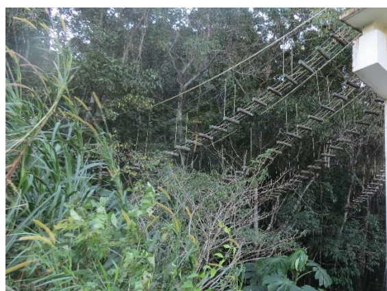
Figura 33. Detalhe das estruturas que ligam a passagem superior de fauna às árvores da vegetação do entorno na BR-101/RJ. Foto: Helio Secco.
