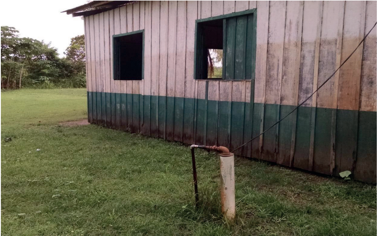
Figura 13 – Poço em escola na comunidade do Retiro, município de Humaitá (AM), à margem esquerda do rio Madeira. As marcas na parede indicam o nível alcançado pelo rio em 2014. O poço explora depósitos sedimentares quaternários
