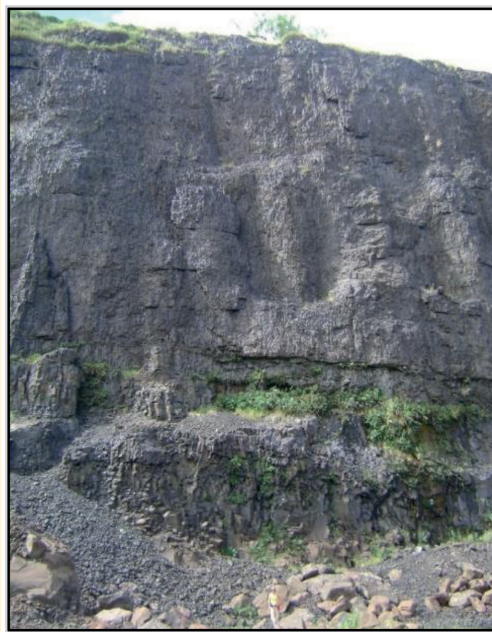
Figura 11 – Parede de pedra de basalto em Ribeirão Preto (SP), com cerca de 50 m de altura
